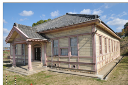
図1-7-46 旧愛知県第二尋常中学校講堂
