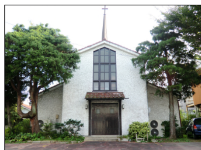
図1-7-48 日本福音ルーテル岡崎教会教会堂
