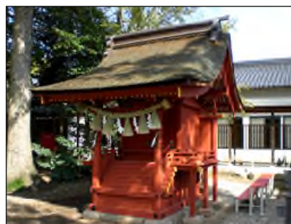
図1-7-40 伊賀八幡宮末社上総社社殿、牟久津社社殿
